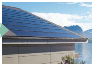
Concetto di impianto fotovoltaico integrato Esempio: swisspearl "Integral Plan"
