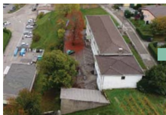
Tetto esistente in tegole marsigliesi.
